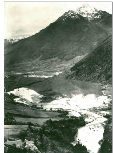
Geschiebe des Bretterwandbaches staute den Tauernbach auf. Es bildete sich ein See auf der Hinterau. Aufnahme aus dem Jahre 1946. Nach der Verbauung des Bretterwandbaches ging man in den späten 1960er-Jahren an die Kultivierung der Hinterau. Heute hat das Gebiet der Hinterau neben seiner landwirtschaftlichen Bedeutung vor allem auch einen wichtigen Stellenwert als Naherholungsgebiet.
