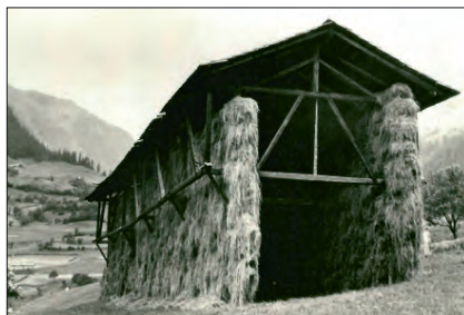
Kornharpe beim Moar in Kaltenhaus: Derartige Bauwerke bezeugen den slawischen Einfluss auf die Ackerbaukultur bis in unsere Bergregion.
