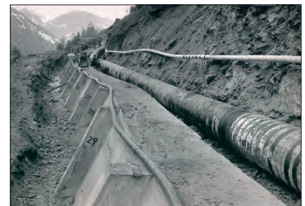
Bau der TAL-Trasse in der Proseggklamm 1966
